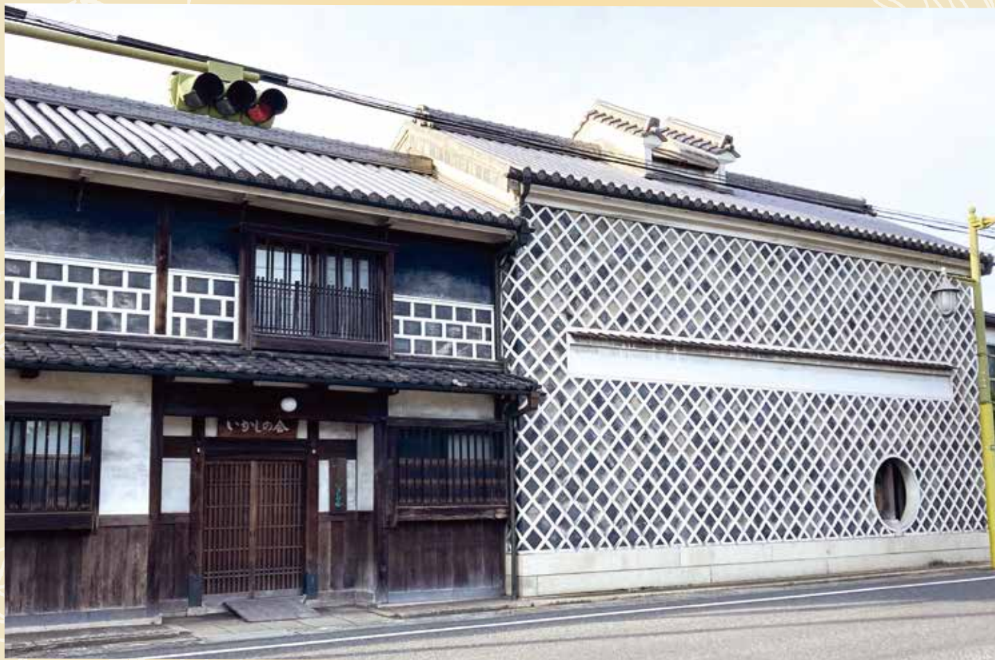
いかしの舎(岡山県都窪郡早島町)
